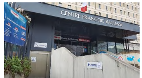
L'entrée principale est accessible par ascenseur
