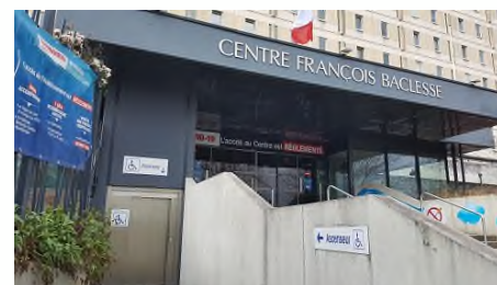
L'entrée principale est accessible par ascenseur
